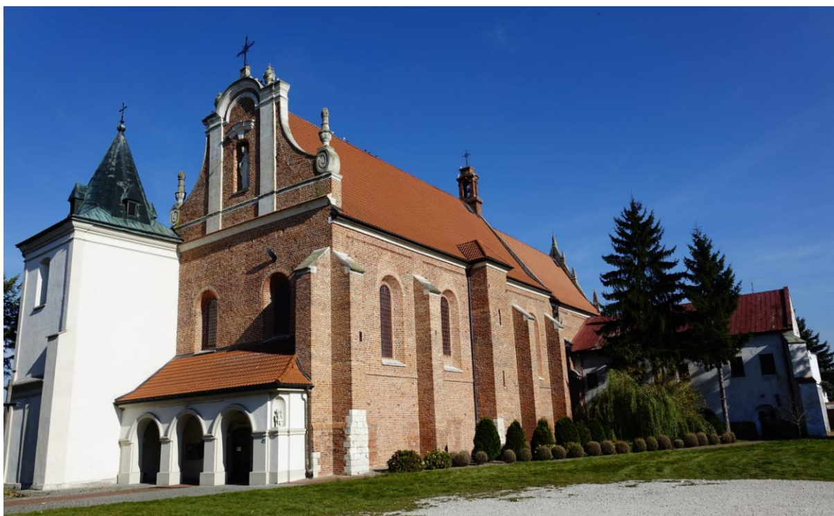
Zdjęcie 4. Kościół pw. św. Stanisława w Nowym Korczynie z widocznym skrzydłem poklasztorным przylegającym do prezbiterium kościoła.
